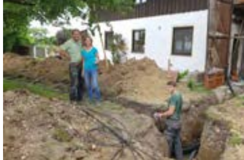
Bauherr Hans Urban und seine gesamte Familie packte beim Bau des Nahwärmenetzes kräftig selbst mit an
